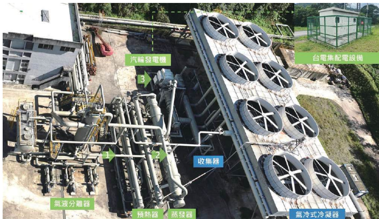
完整的地熱發電流程需要各部件之間的協調配合
